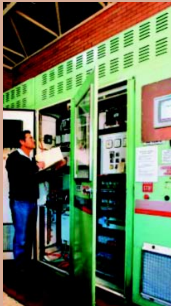
Centennial Myuna 的 Greg Briggs 检查罗克韦尔自动化设计的矿用提升绞车的新数字安全与控制系统。
